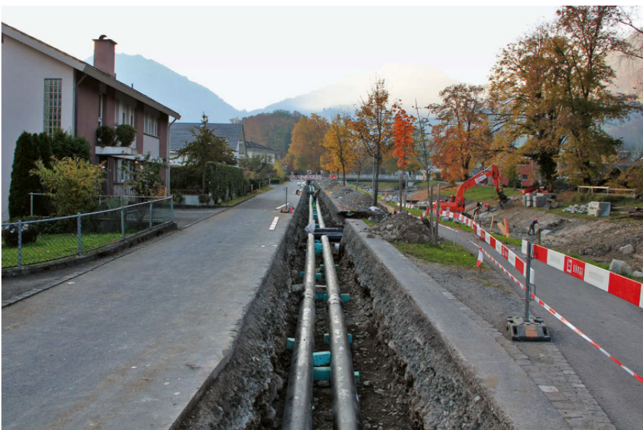
Leitungsbau des Wärmeverbunds Alpnach (OW)
