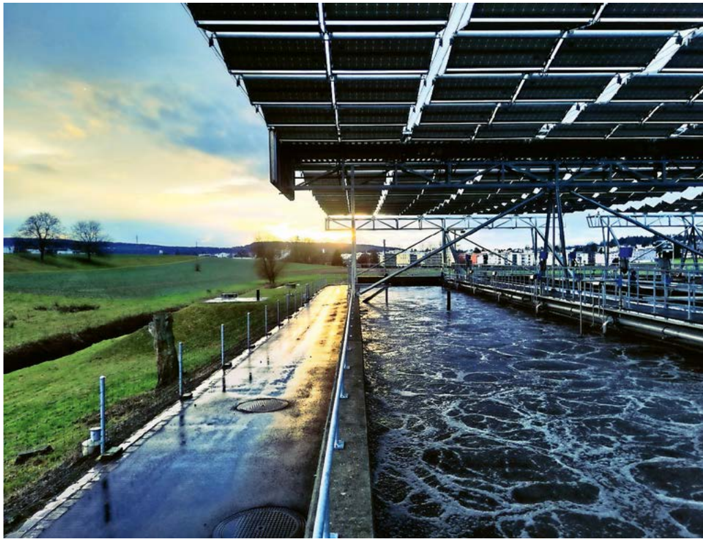
Ein Solarfaltdach optimiert die Abwasserreinigung, da durch den Schatten das Algenwachstum in den Nachklärbecken zurückgeht. Quelle: ARA Eich
