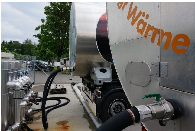
Photo: camion raccordé à la station de couplage (au centre) pour l'échange thermique (photo: erzo).
