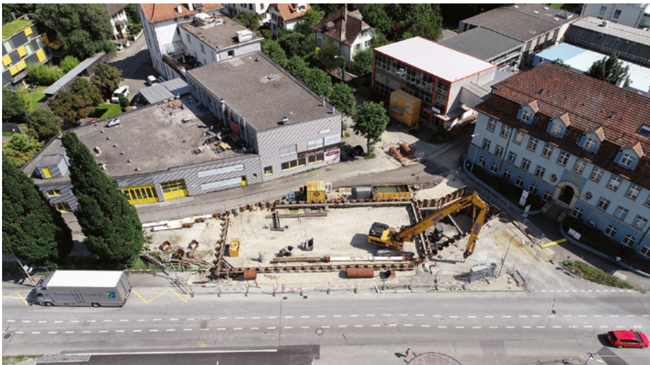
Fig. 3 Das Bauprojekt des Pumpwerkes musste aufgrund von Anpassungen zugunsten der Archäologie im Untergrund angepasst werden. (Foto: Energie Service Biel/Bienne)
