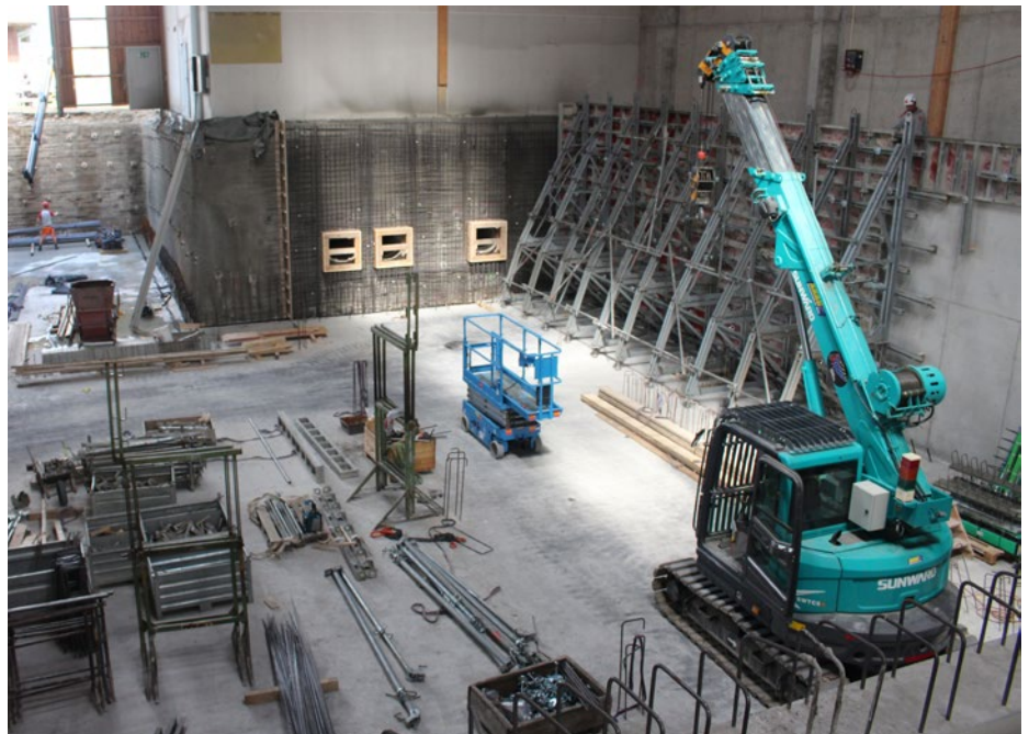
Die im Bau befindliche Heizzentrale mit dem Bunker für die Hackschnitzel.
