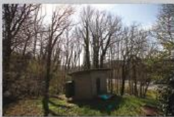
Al Roccolo (Stazione di pompaggio)
