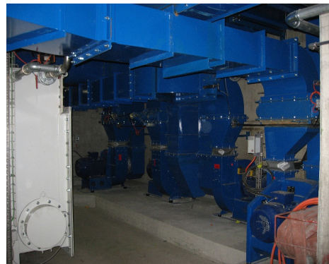
Abb 2: Installierte Unterwindgebläse
