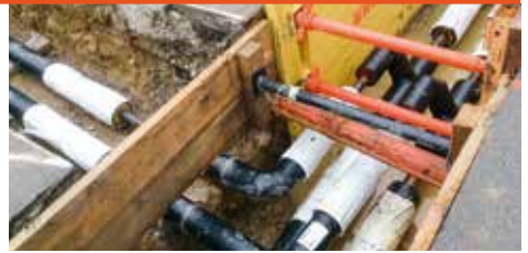
Leitungsbau Wärmenetz Jegenstorf
