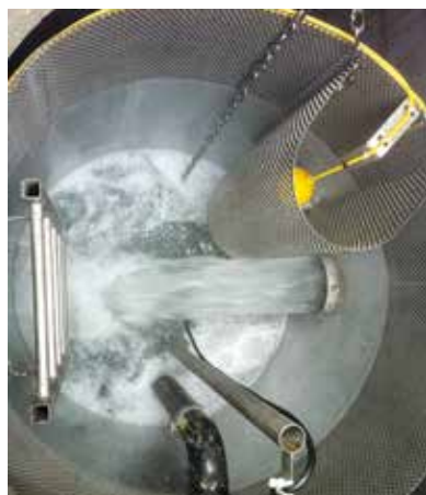
Schachtwärmetauscher
