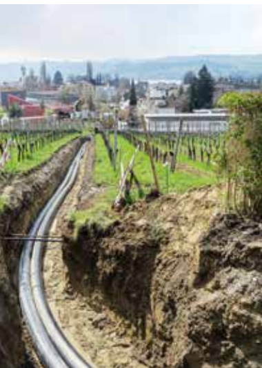
Leitungsbau Wärmenetz Uetikon am See
