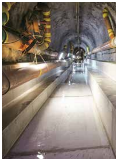
Abwasserkanal mit Sohlenwärmetauscher
