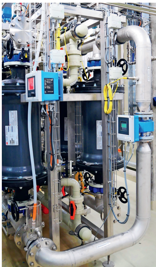
Fig. 2 Die Membrananlage ist das zentrale Element der chemischen Faulwasserbehandlung. Die Membranen selbst befinden sich in geschlossenen, zylinderförmigen Behältern (Foto rechts oben). Das Stripping erfolgt entlang von kapillarförmigen Membranen (Foto rechts unten).
