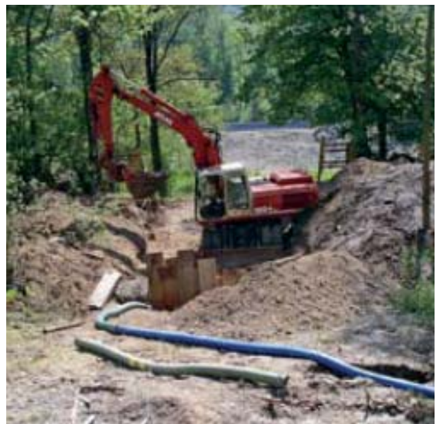
Abbildung 3/4: Bau der Fernleitung für das gereinigte Abwasser aus der ARA Hard, Winterthur, in den Neubau Tösswiesen, Neftenbach
