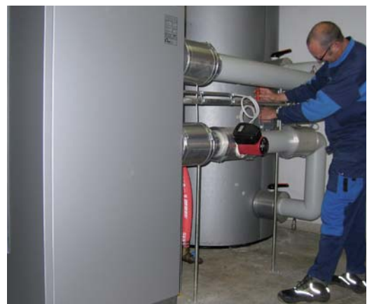
Abbildung 5/6: Die ARA Meilen versorgt umliegende Wärmeabnehmer schon seit mehreren Jahrzehnten mit Abwasserwärme. Sie liefert sowohl kalte Fernwärme (Wärmetauscher, Abbildung links) als auch warme Fernwärme (Wärmepumpe, Abbildung rechts). Planung, Finanzierung, Bau und Betrieb der erforderlichen Anlagen erfolgen durch einen Contractor, in diesem Fall durch die Elektrizitätswerke des Kantons Zürich (EKZ), welche die Kunden mit Wärme versorgen. Die ARA Meilen stellt die Abwasserwärme (gereinigtes Abwasser) und die Räumlichkeiten für die Infrastruktur zur Verfügung.
