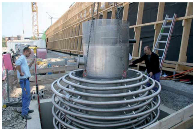
Abbildung 11/12: In der Sportanlage Heerenschürli, Zürich, wird das Abwasser «inhaus» zur Wärmerückgewinnung genutzt. Abbildung links: Einbau des Wärmetauschers; Abbildung rechts: Wärmepumpe und Steuereinheit im ersten Stockwerk der Sportanlage (FEKA Energiesysteme AG, Bad Ragaz)
