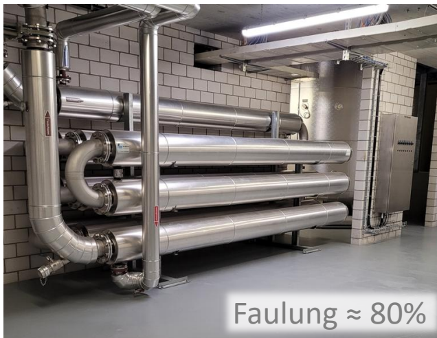
Schlammerwärmung
